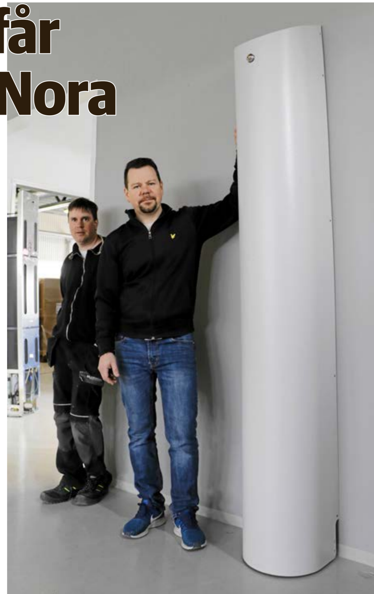
Så här ser den mobila boendesprinklern ut visar Fredrik Lindberg och Andreas Lindström. Den placeras i ett rum och fyller snabbt lokalen med vattendimma om det skulle börja brinna.
